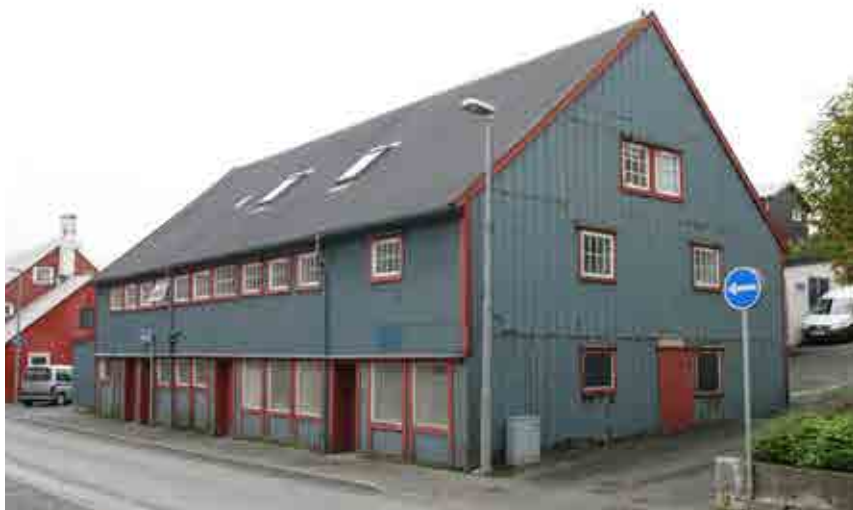
Hansens pakkhús (Vaskartíð) í Tórsgøtu. Kongligi einahandilin bygdi húsið í 1832, partvíst á grundina, har stóra pakkhúsið hjá Rybergshandlinum stóð. Tórshavnar kommuna eigur bygningin og er farin undir at umvæla hann.
