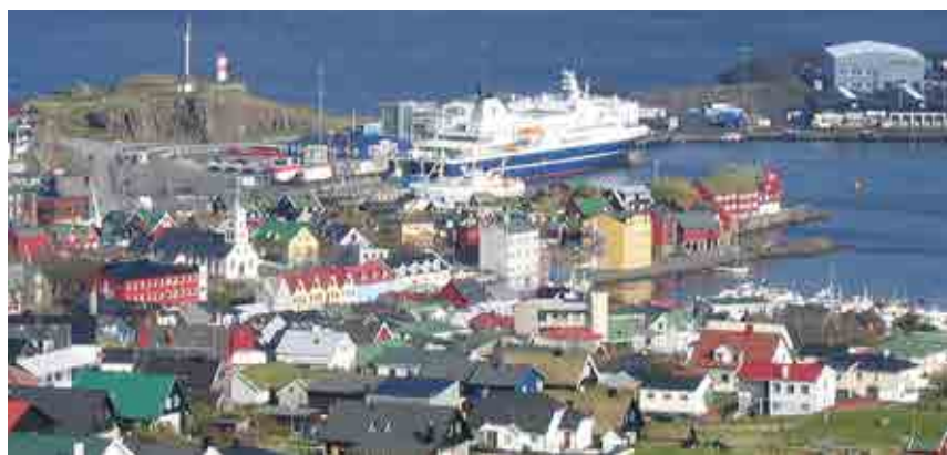
Útsýni av Oyggjarvegnum móti Tinganesi, havnarlagnum og Skansanum.
