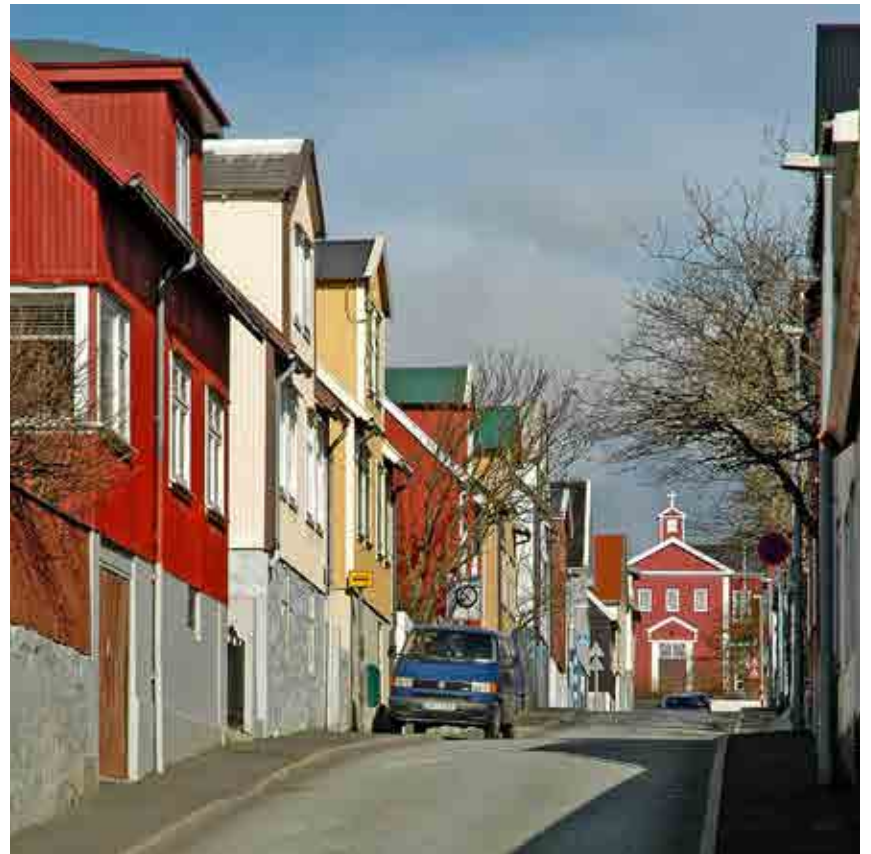
Tróndargøta, ein vøkur røð av húsum við kjallara, trimpli og stórum miðkvisti. Fremsta húsið hevur skorið trævirki um vindeygum og á útveggjum.
