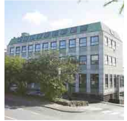
Føroya Banki við Steinatún, ein bygningur við útlenskum fyrimyndum.
