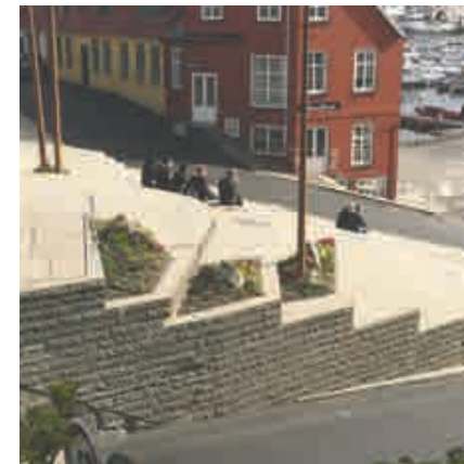
Í nýggju trappuni eru nøkur av trinunum so mikið stór, at tey kunnu virka sum ein lítill pallur. Tað er somuleiðis lætt at fáa streym, umframt kann ljósið skifta litir og stýrast í mun til virksemi.
